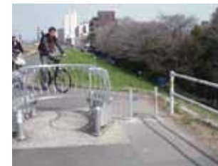
写真■堤防との接続部
