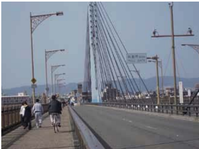
写真■柱間に多数ケーブルを張り強風への配慮がされている斜張橋
