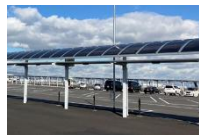
バスシェルターへの ペロブスカイト太陽電池の設置 提供: 積水化学工業株式会社
