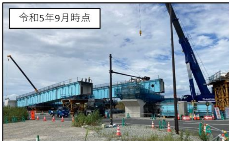
（仮称）夢洲北高架橋架設状況
