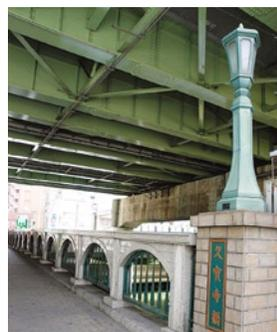
現在の橋は、昭和14(1939)年、永久橋化され三径間ゲルバー式鉄筋コンクリート桁を採用した橋となり、平成9(1997)年には橋が美装化され装いも新たになった。スッキリとした照明灯が目を引くこの橋の途中からは、真上を走る阪神高速1号線の長堀入口にもつながっている。
