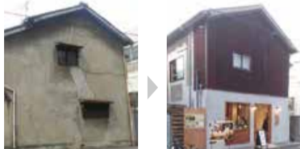
改修イメージ(改修前→改修後)
