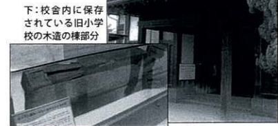
下:校舎内に保存されている旧小学校の木造の棟部分
