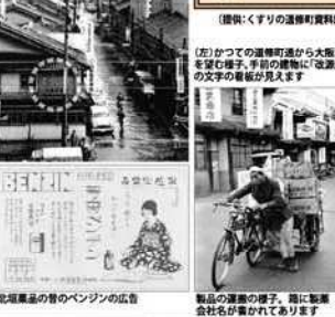
(左)かつての道修町から大坂城を望む様子、手前の橋脚は「瀧」の文字の看板が見えます
