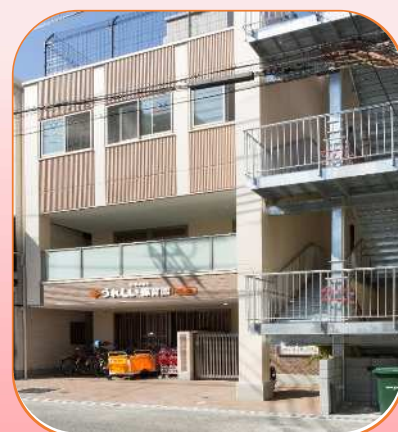
鉄筋コンクリート4階建
