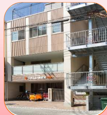
鉄筋コンクリート4階建
