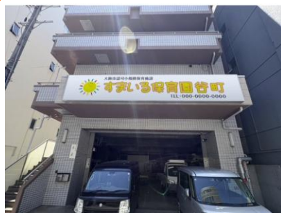
マンション2階部分
