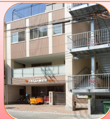
鉄筋コンクリート4階建
