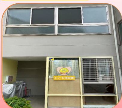
鉄骨3階建ての1階です
