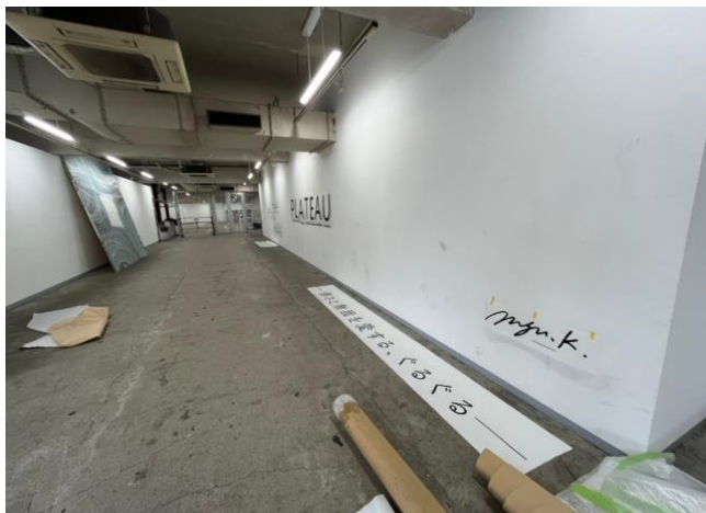
2階 入口付近設営の様子
