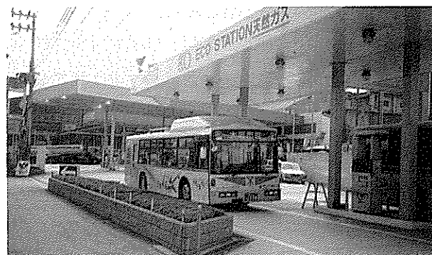
大阪ベイエリアトラックエコ・ステーション
