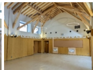
国産木材で建築した獣舎 (天王寺動物園内ふれあい家畜舎)
