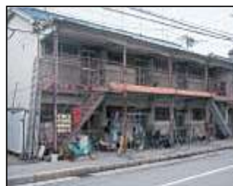
<従前建物>老朽木造住宅
