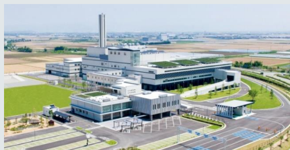
廃棄物発電施設
