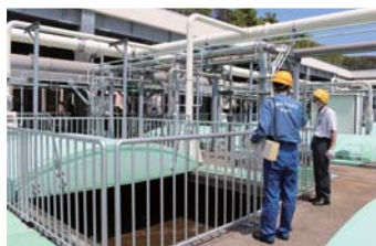
微生物が下水中の汚濁物を吸収・分解している反応槽
