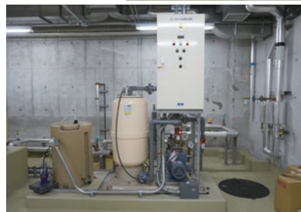
城東区複合施設の地下に設置されている「雨水ろ過装置」
