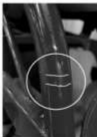
⑤レッグパイプの変形 推測される原因：繰り返し衝撃による疲労
