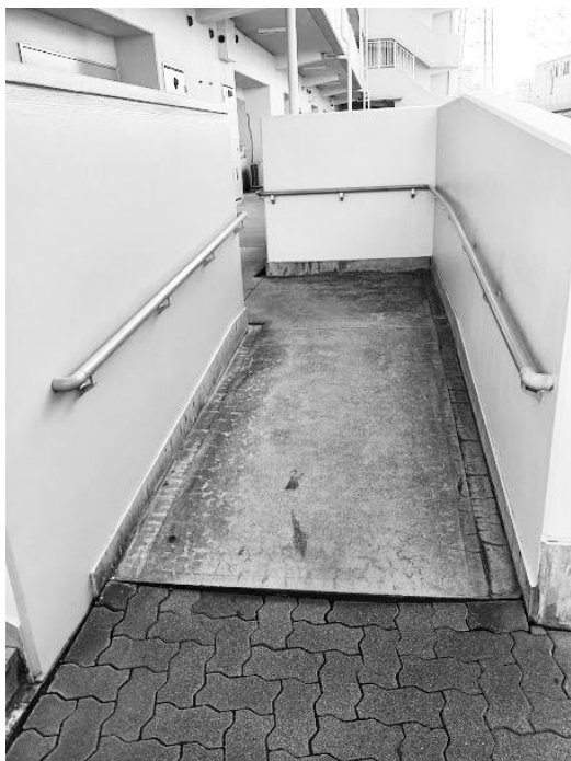
共用廊下のスロープと手摺
