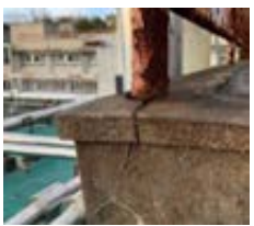
支柱部付近の損傷
