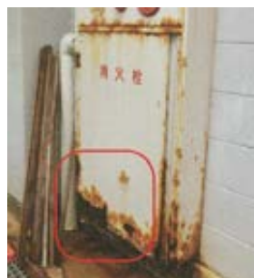
消火栓箱の損傷♦10
