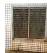
吸入口の腐食
