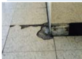
床仕上げ材の剥がれ
