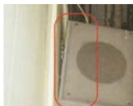
拡声装置の取付不良◆3
