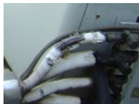
配管断熱材の剥れ
