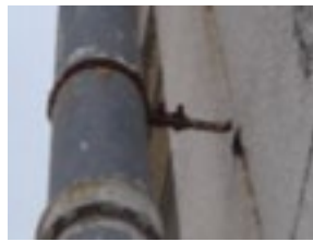
壁取付金物の損傷
