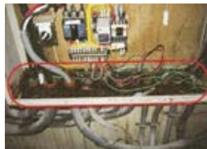
盤の腐食と変色◆7
