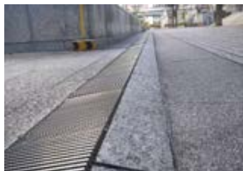
側溝の浮き
