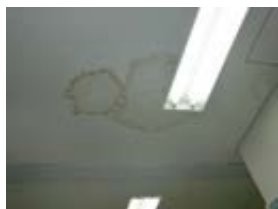
漏水による染み
