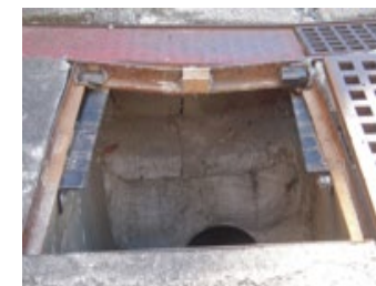
枠の損傷（蓋の浮きの原因）
