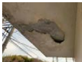
庇部の仕上げ材の剥れ
