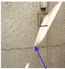
仕上げ材のひび割れ
