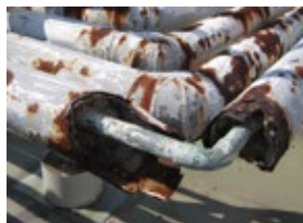
配管断熱材の損傷
