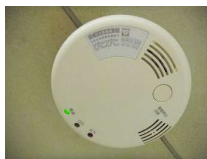
ガス漏れ警報器
