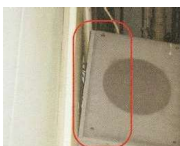
拡声装置の取付不良 ※3
