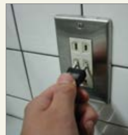
濡れた手でコンセントに触れない
