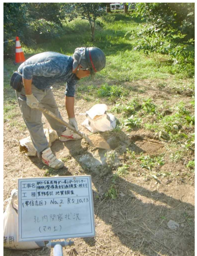
調査孔閉塞 (マサ土)
