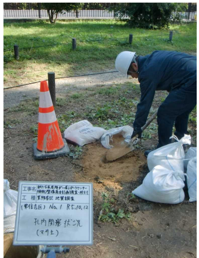
調査孔閉塞(マサ土)
