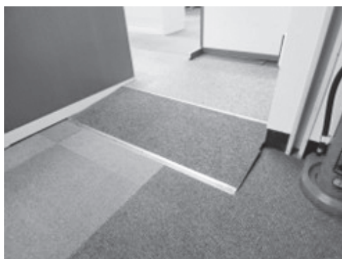
写真5 段差解消スロープ
