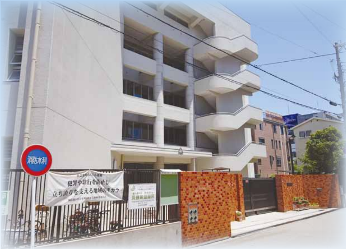
大阪市立野田中学校（災害時避難所）
