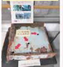
淀川大橋の銃弾跡
