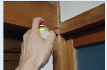
殺虫剤を柱のすき間に注入
