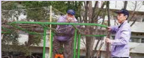
ネットかけ作業 下福島公園
