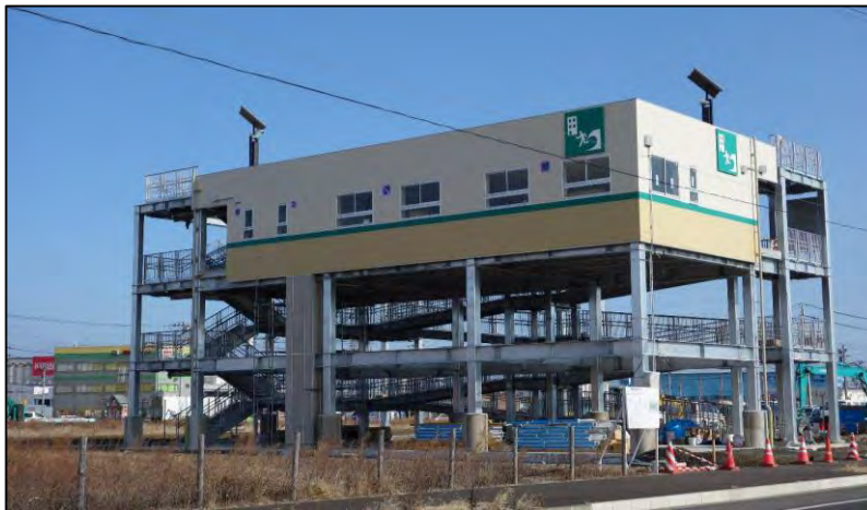
津波避難タワー(仙台市宮城野区)
