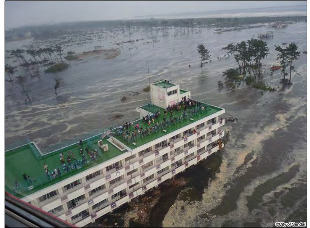
津波で孤立する荒浜小学校（H23年3月11日 仙台市）
