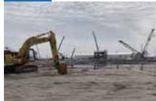
建築工事の様子
