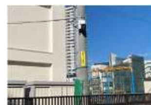
設置した防犯カメラ
