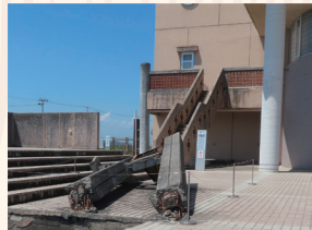
海は東側にあるが北側に押し倒された時計台。校舎にぶつかった津波が向きを変えたことがわかる。
