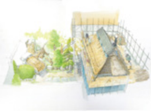
茅屋根葺き替え作業風景
