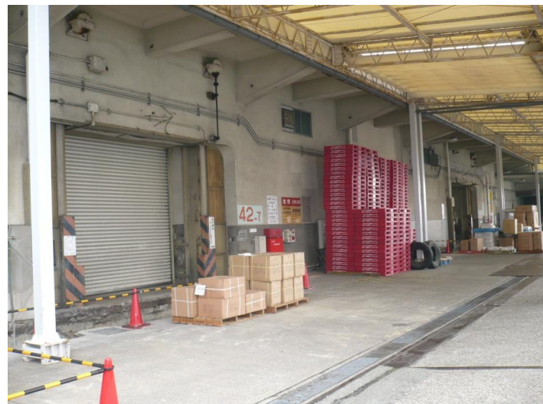
③防潮堤[港湾施設]と安治川8号上屋
