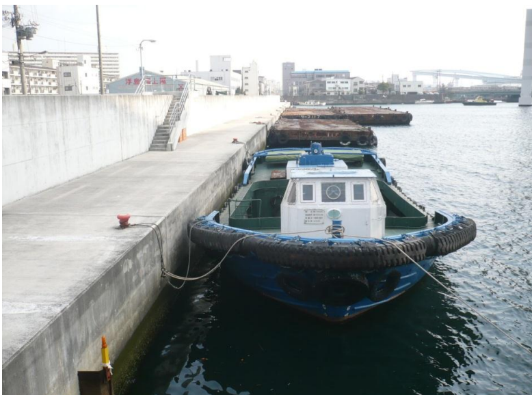
②防潮堤[海岸保全施設]と物揚場(天保山運河内)
