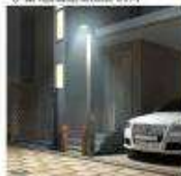
◇蓄電池連動LED街灯
