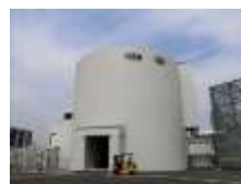
■ 多目的大型実験棟
