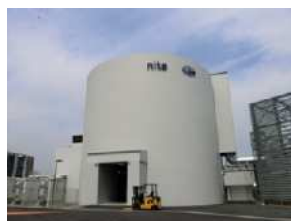
多目的大型実験棟
