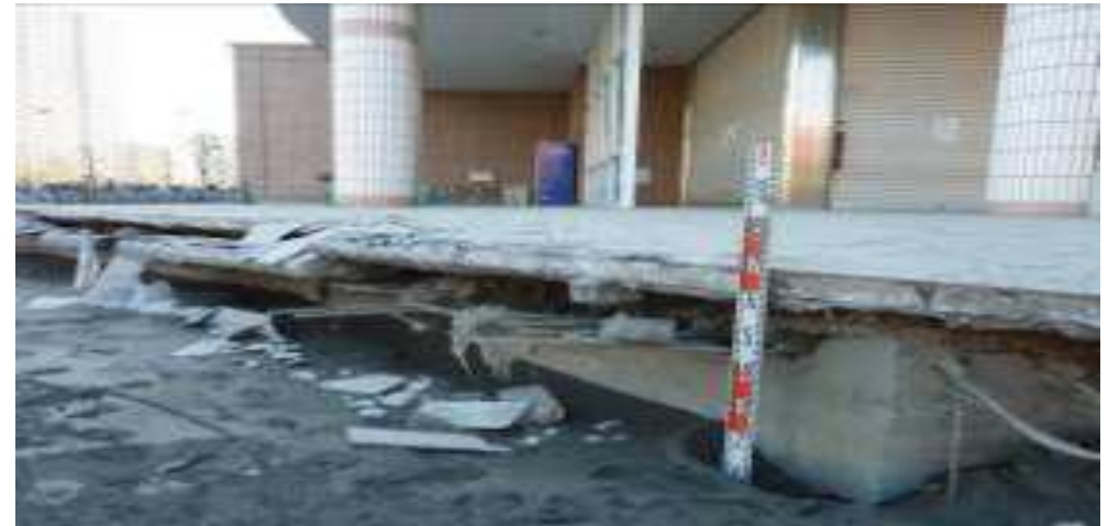
千葉県ホームページ「東日本大震災液状化報告書」から抜粋 浦安市での噴砂と地盤沈下
