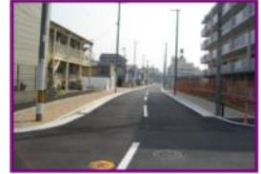
主要生活道路（生野東西線） 平成25年3月・平成26年3月 完成（延長約300m）
