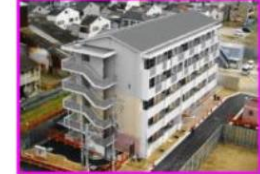
改良住宅（生野東住宅2号館1期棟） 平成24年3月 完成（22戸）
