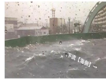
平成30年台風21号 木津川水門下流付近の状況
