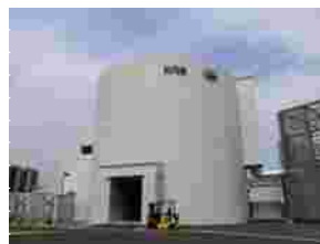
多目的大型実験棟
