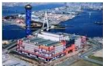
汚泥集中処理システム (舞洲スラッジセンター)
