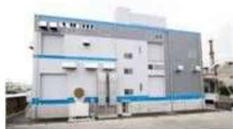
消化ガス発電 (PFI事業) (津守下水処理場)
