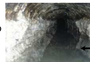
下水管内に油分が付着している
