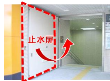
止水扉の設置事例
