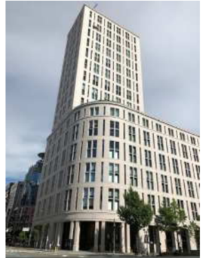
本町ガーデンシティ 高さ: 132m(地上27階/地下2階) 竣工: 2010.10開業 容積: 1,300% 用途: オフィス・ホテル複合 備考: 国内初進出セントレジスホテル
