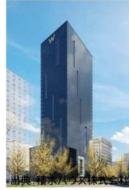
積水ハウス 高さ: 約120m(地上27階/地下1階) 竣工: 2021.2開業予定 容積: 1,300% 用途: ホテル 備考: 国内初進出Wホテル
