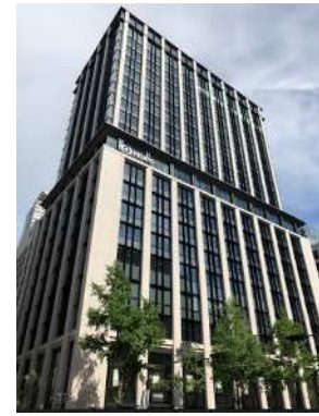
三菱UFJ銀行 高さ: 101m(地上21階/地下3階) 竣工: 2018.8開業 容積: 1,400% 用途: オフィス(銀行)
