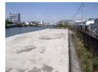
一級河川 六軒家川 防潮堤補強【完成】
