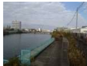
一級河川 六軒家川 防潮堤補強【工事中】
