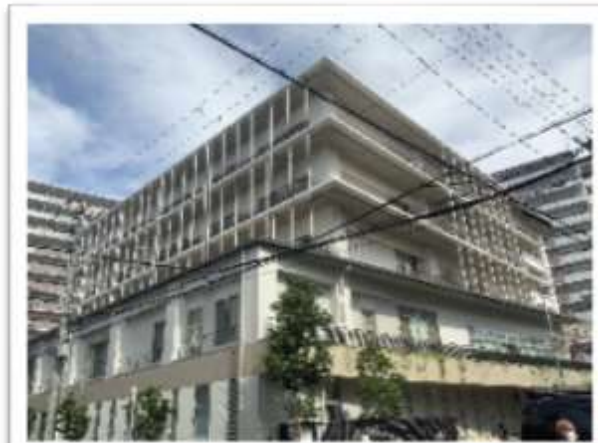
②：正面が病院、その背面に2つの市営住宅
