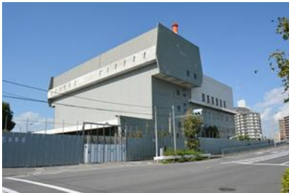
解体が滞るゴミ処理場
