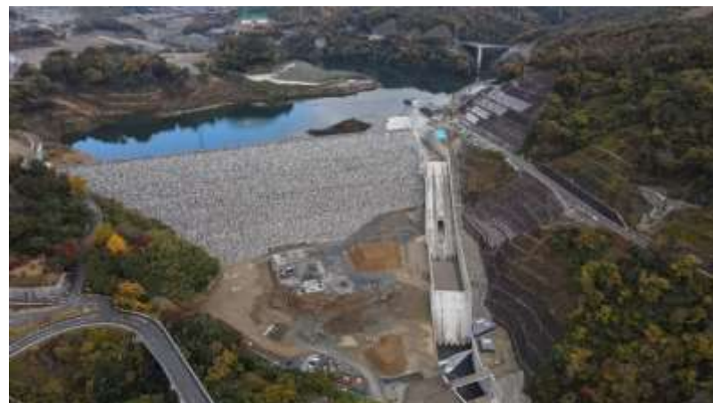
安威川ダム建設事業 (茨木市)
