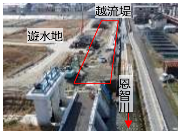
恩智川(法善寺)多目的遊水地 (柏原市)
